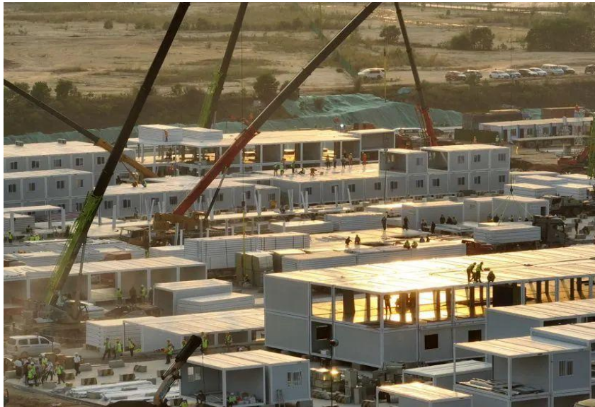
图5 知识城方舱医院建设现场
